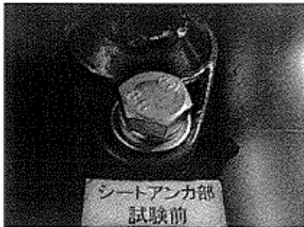
試験前 シートアンカ 右側 後
