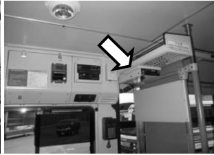
仕切板上部(荷物棚下)
