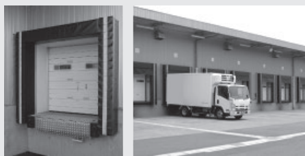
搬入口のドックシェルター ドックシェルターにピタリと接車
