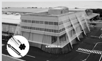
自社の炭素繊維素材を耐震補強に用いた 小松マテール日本社棟
