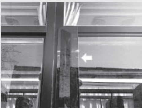
雨の浸入を防ぎ、雨天でも窓開け換気ができる
