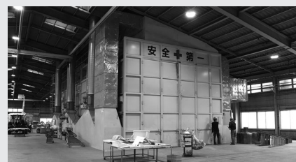
国内最大級の乾燥炉付の塗装ブース
