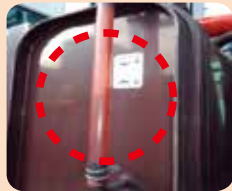
作動油不足・劣化汚れ
