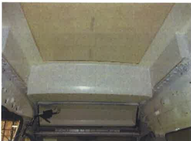
室内車両前方ルーフ部
