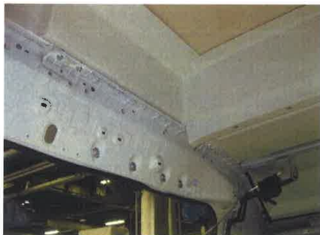
室内車両前方左ルーフ部
